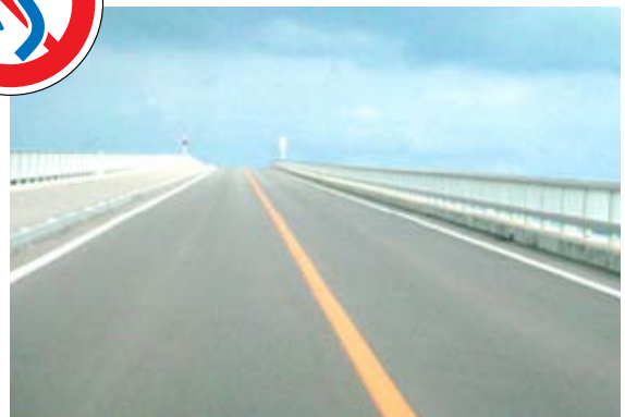
เส้นที่บัสเหลืองกลางถนนแสดงถึงเขตพื้นที่ห้ามแซง
